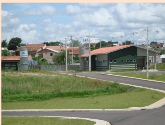
FIGURA 28 – VISTA DA ÁREA ADMINISTRATIVA DA ETE IGUAÇU Fonte: SANEPAR, 2008
