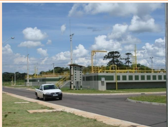
FIGURA 30 – VISTA DA ÁREA DOS RALF'S DA ETE IGUAÇU Fonte: SANEPAR, 2008
