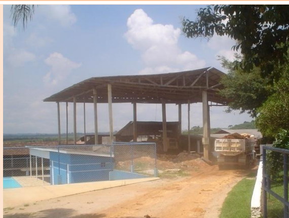
FIGURA 24 – VISTA 1 DA OLARIA SALESBRAM
