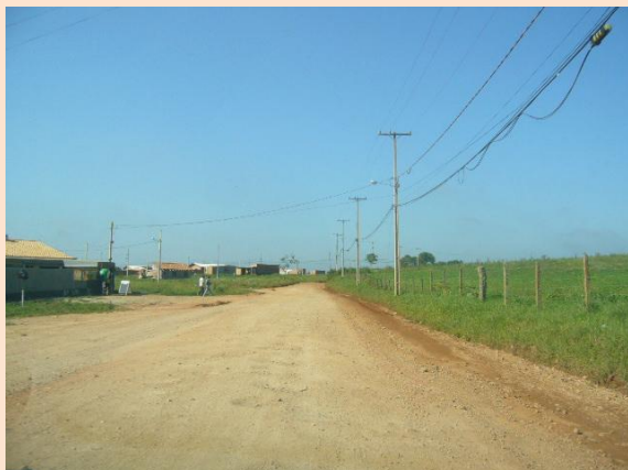
FIGURA 35 – VISTA DA AV. NOSSA SENHORA APARECIDA Fonte: ECOTÉCNICA, 2008
