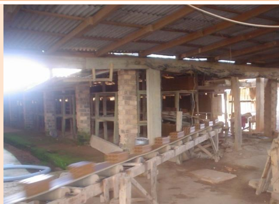
FIGURA 25 – VISTA 2 DA OLARIA SALESBRAM
